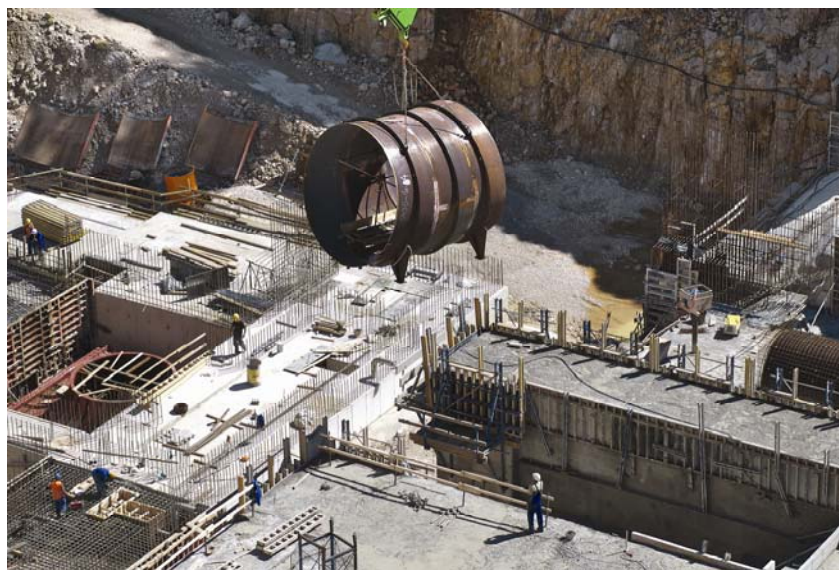
Ugradnja koljena tlačnog cjevovoda s pomoću kranске dizalice
