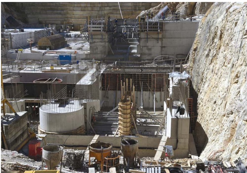
Gradilište strojarnice u početku glavnih radova
