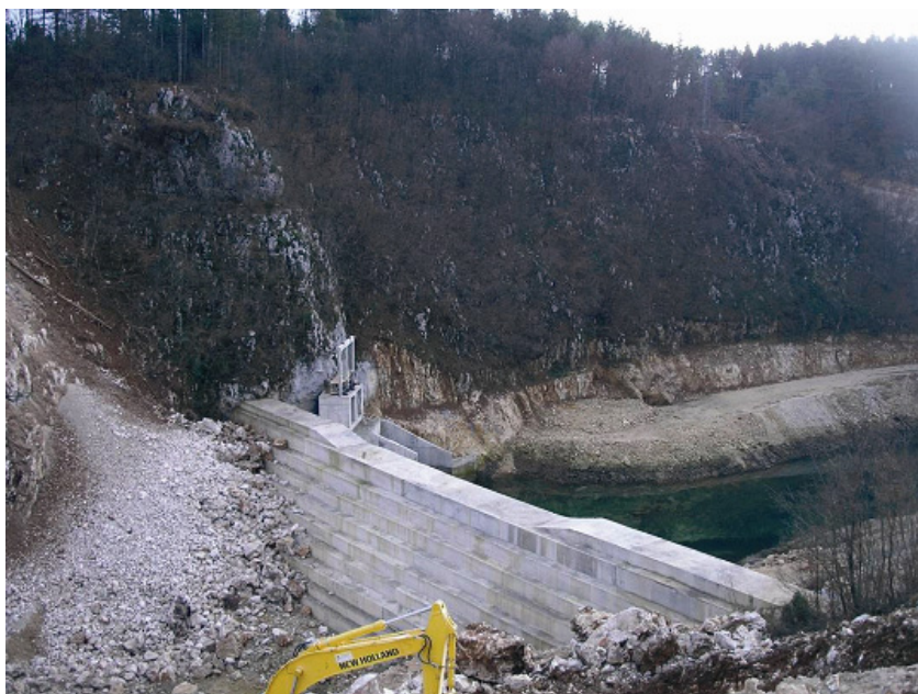
Uzvodni zagat s ulaznim dijelom optočnog tunela
