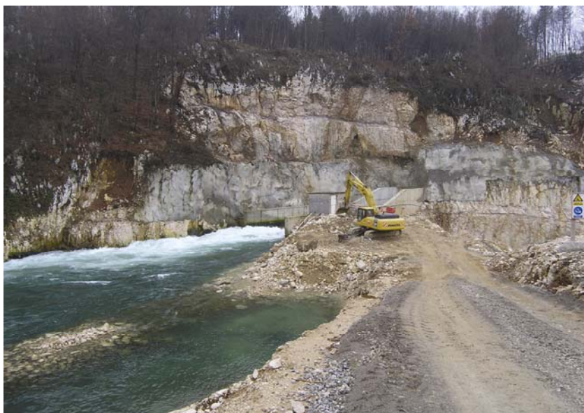
Nizvodni zagat i ispus optočnog tunela
