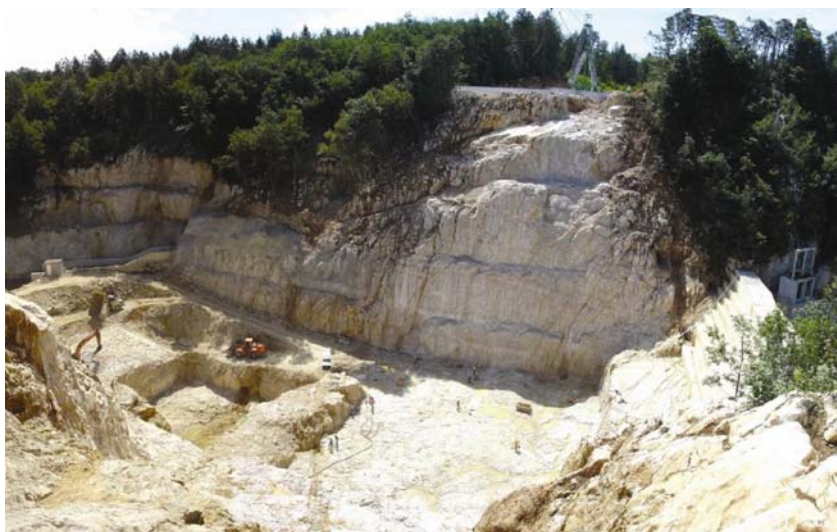
Sanacija rasjedne zone u građevnoj jami
