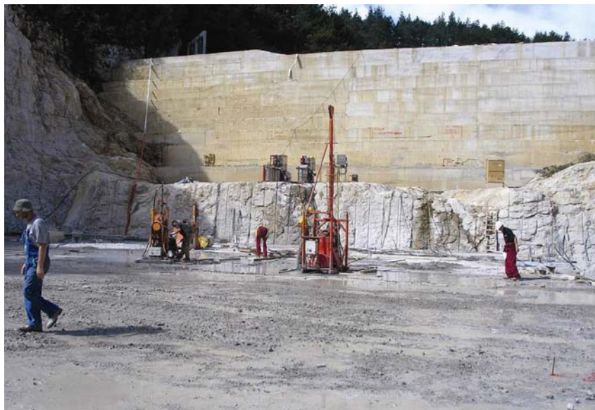
Injektiranje ispod temelja brane
