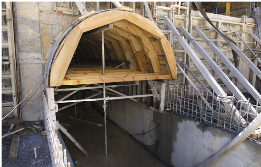
Oplata temeljnog ispusta
